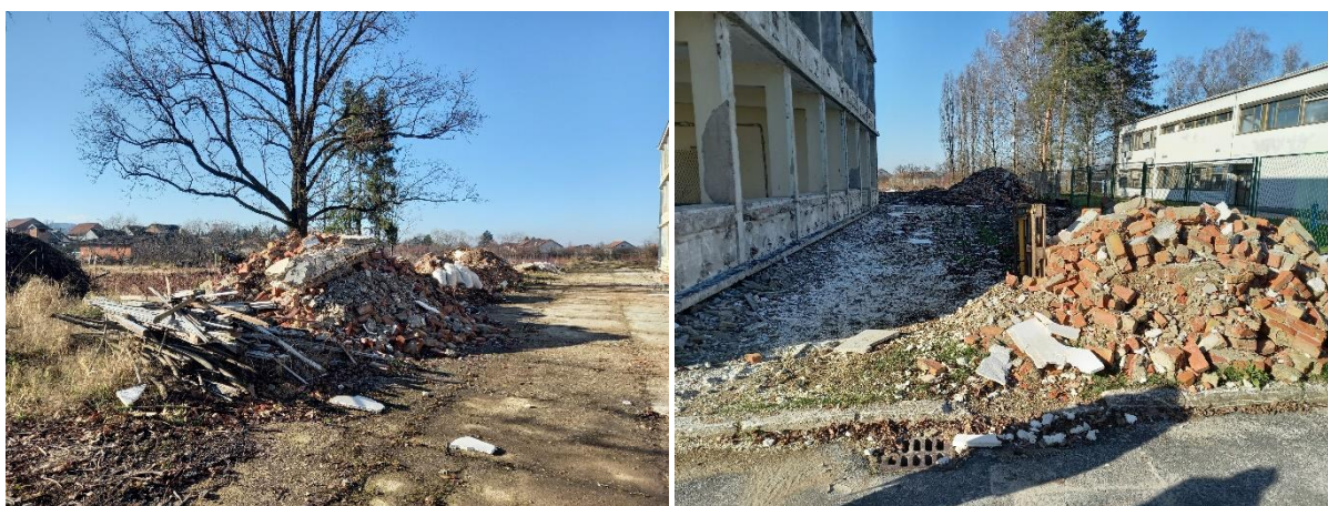
Slika 4. Otpad nastao tijekom dosad provedenih pripremih radova (desno: otpad koji će biti odvezen i zbrinut do kraja srpnja 2022)
